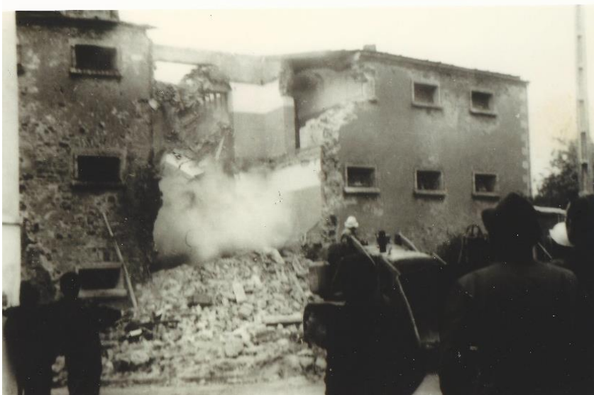
Démolition en cours de la prison Photographie, coll. Jacques Ethieux
