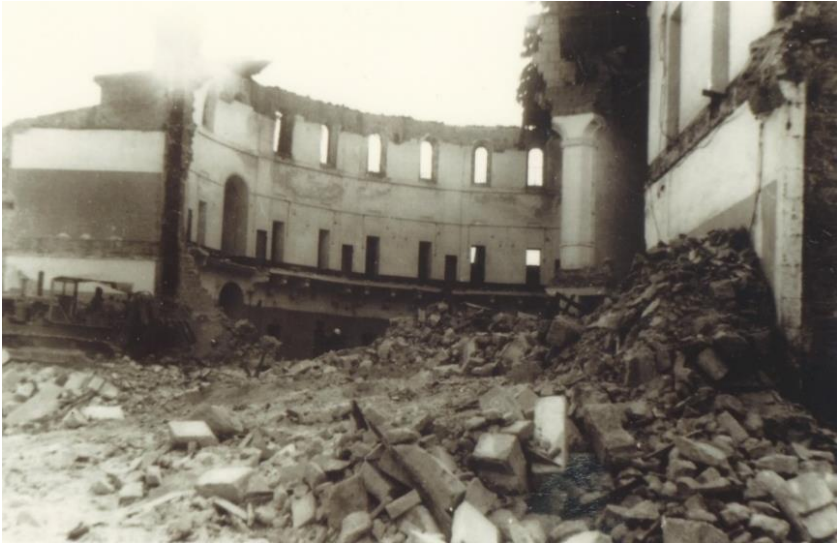
Démolition en cours de la prison Photographie, coll. Jacques Ethieux
