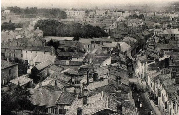
Panorama du vieux centre de Bressuire avec à l'arrière plan l'alignement des maisons de la rue Waldeck-Rousseau. Photographie prise du haut du clocher de Notre-Dame.
