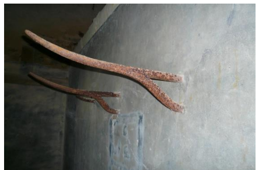
Crochets fixés dans le mur d'un échaudoir Cliché de l'auteur
