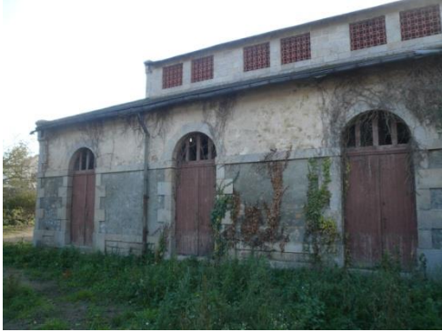
Façade Nord de l'abattoir avec ses claustras et les portes de trois échaudoirs Cliché de l'auteur
