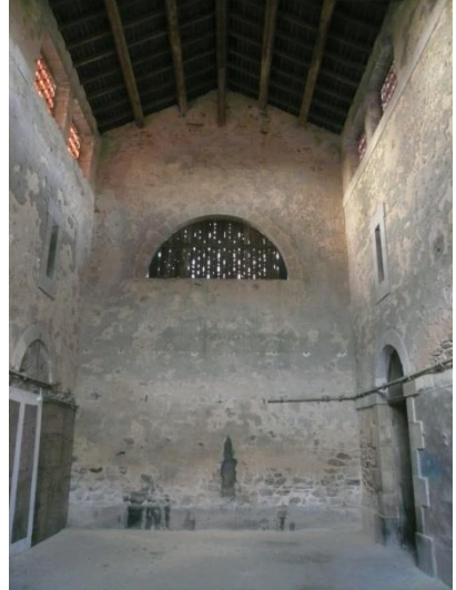
Cour centrale éclairée par des claustras de briques de Montchanin et surmontée d'une charpente apparente Cliché de l'auteur
