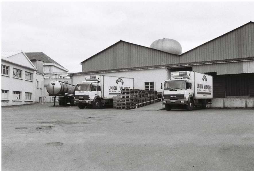
Quai de chargement Union Viandes Source : Arch. Mun. Bressuire.
